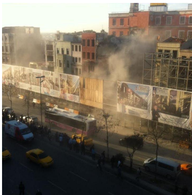
Fig. 9. Demolition of the buildings in Tarlabası.
